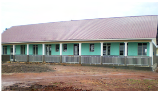
November 2008: Die Ambulanz ist fast fertiggestellt
